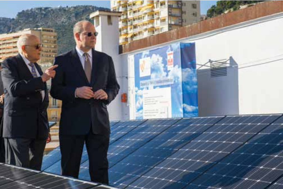
Visite de l'installation photovoltaïque du Château Amiral. L'électricité produite est utilisée pour le fonctionnement des parties communes de la copropriété. 30 novembre 2017 Crédit Photo : Axel BASTELLO Palais Princier
